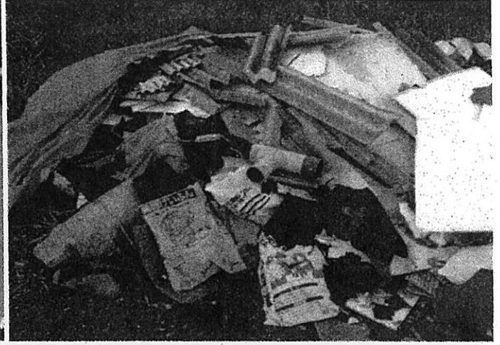
写真14: ⑨スレート集積状況 その2 写真7のブルーシートの下
