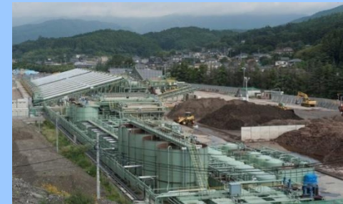
除塩設備 (現状維持)
