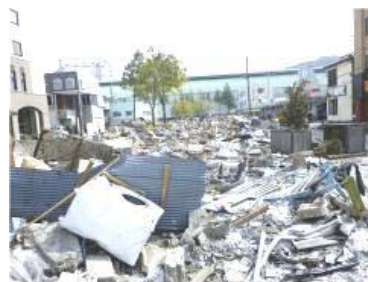
岩手県釜石市(平成23年4月撮影)
