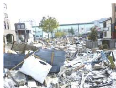
岩手県釜石市(平成23年4月撮影)
