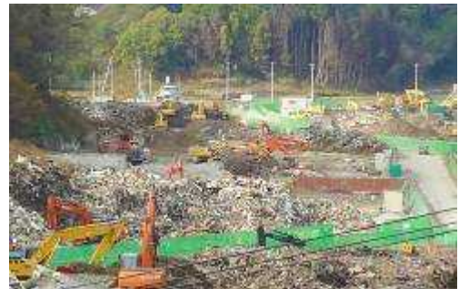
解体 (H24年11月撮影)
