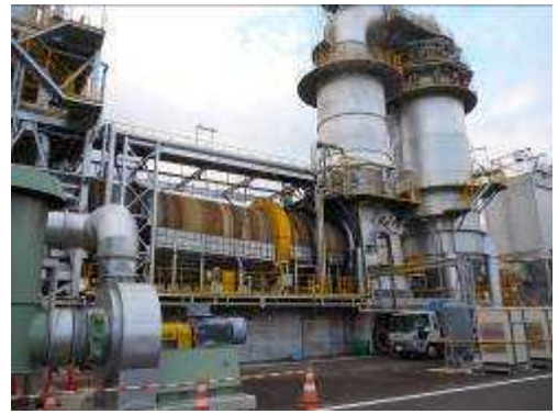
宮城東部ブロックの仮設焼却炉（2基） (1号炉 H24.10.12 本格運転開始 2号炉 H24.11.30 本格運転開始)
