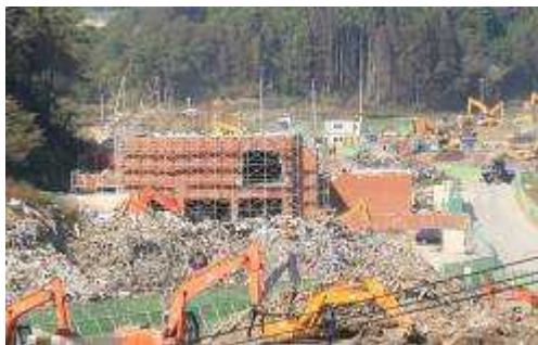
解体前 (H24年2月撮影)
