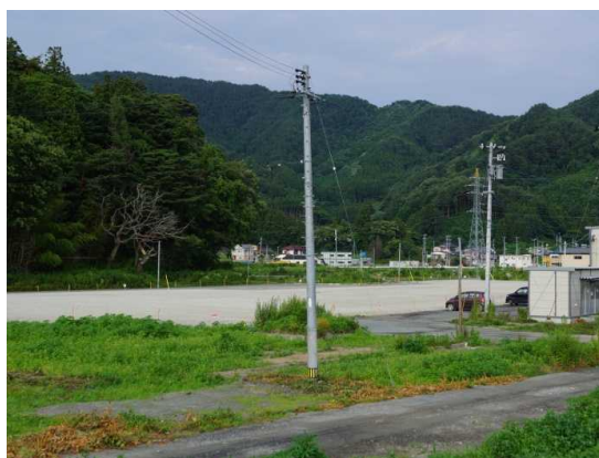
解体後 (H25 年 7 月 10 日撮影)
