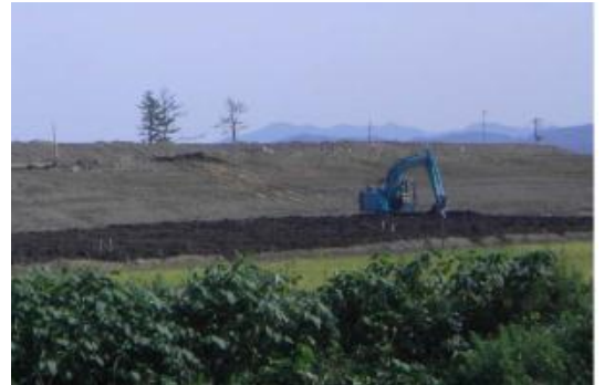
野田村の都市公園事業整備工事 (H25 年 8 月開始)
