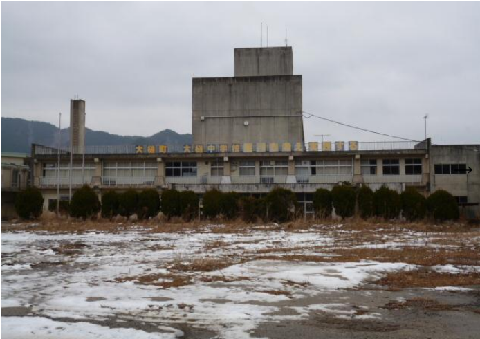
解体前（H25年2月15日撮影）
