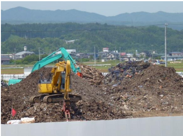
供用中（H24年6月29日撮影）
