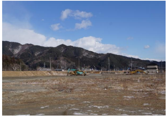
解体後（H26年2月5日撮影）
