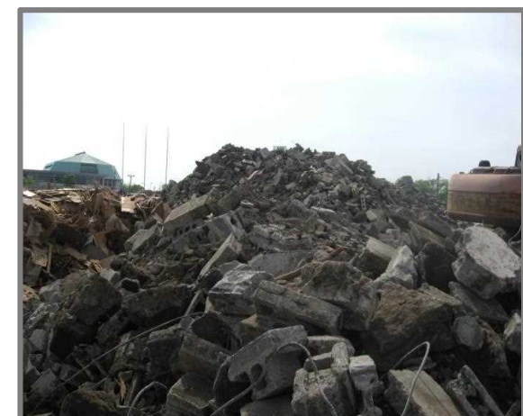
仮置状況(コンクリートブロック)
