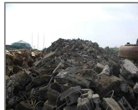
仮置状況(コンクリートブロック)
