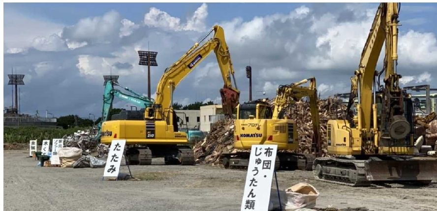
【仮置場全景写真】
