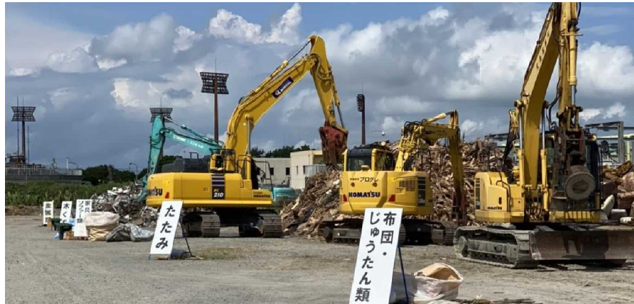
【仮置場全景写真】
