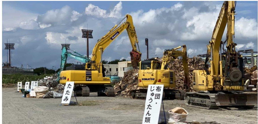
【仮置場全景写真】
