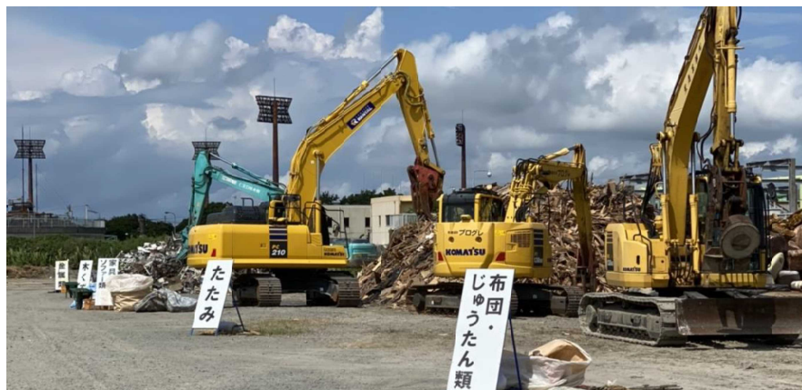
【仮置場全景写真】
