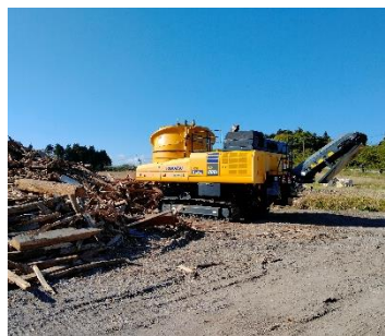
仮置場：珠洲市ジャンボリー跡地 移動式破砕機（稼働中）
