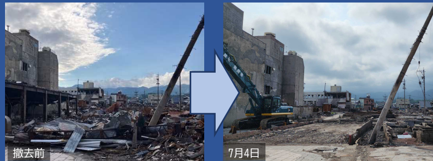
輪島朝市における解体・撤去工事
