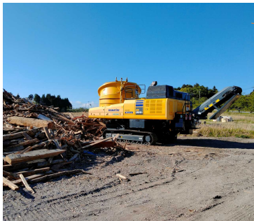
珠州市ジャンボリー跡地仮置場： 移動式破碎機（稼働中）
