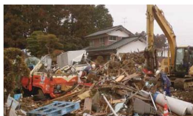
民地の災害廃棄物の撤去（仙台市）
