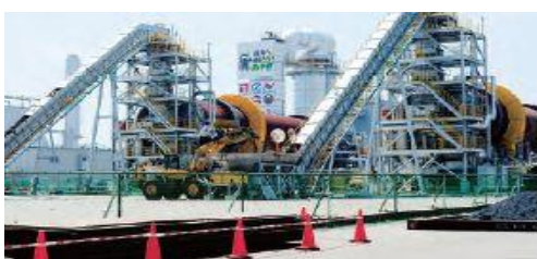
仮設焼却施設（石巻地区）
