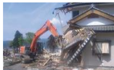
民家解体作業（陸前高田市）
