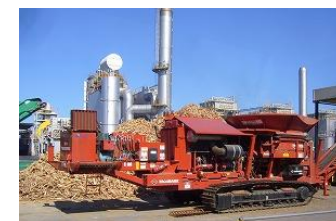
破碎機と木質バイオマス発電施設
