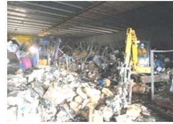
水産系廃棄物撤去作業
