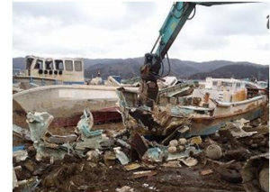
重機による被災船舶の処理
