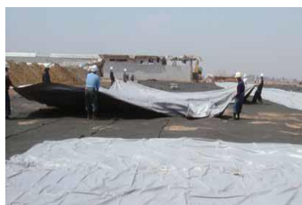
仮置場の設置（仙台市）
