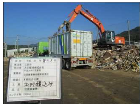
D.Waste-Net メンバーによる災害廃棄物処理の様子
