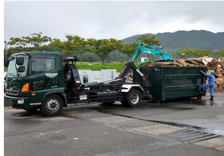
写真：仮置場からの搬出状況
