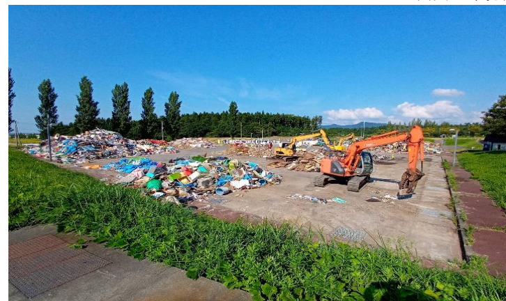
写真：仮置場の状況 (令和4年8月3日からの大雨)
