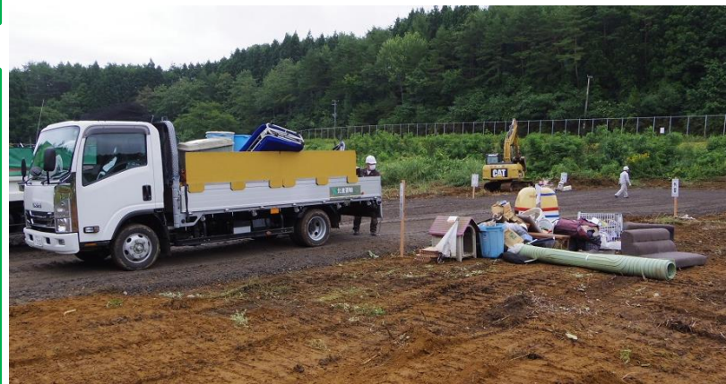
写真：仮置場の状況
