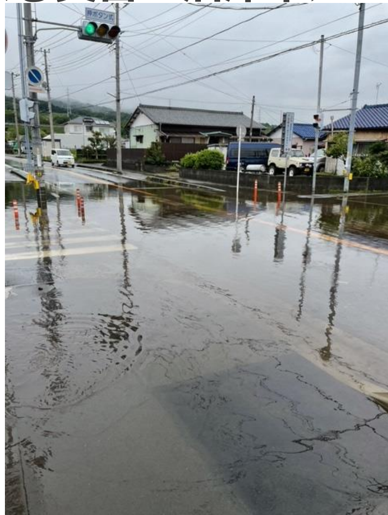
浮島地区 浸水現場
