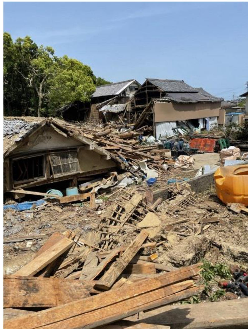
局所的な突風により複数の倉庫等が倒壊被害
