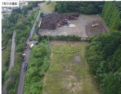
土砂仮置場 (旧小嵐中学校)
